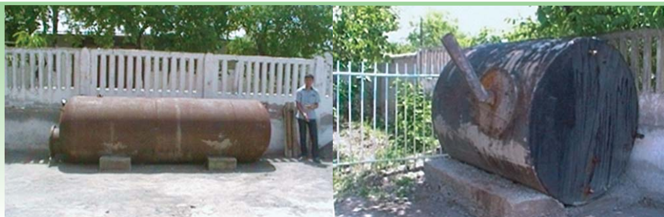
Метантенк и газгольдер биогазовой установки (Эргашев С., ФерПИ)
