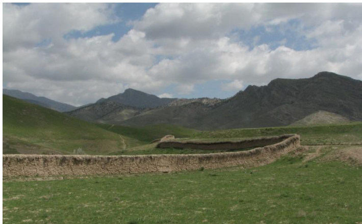
Рис. Ограждение участка глиняным дувалом
